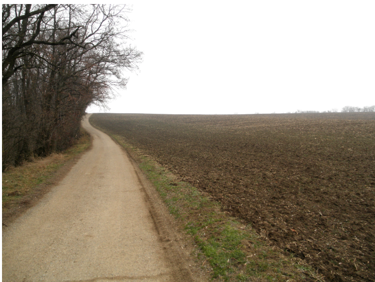
Hlavní polní cesta – dnes stále, i nadbytečně, zpevňované asfaltem či betonem
